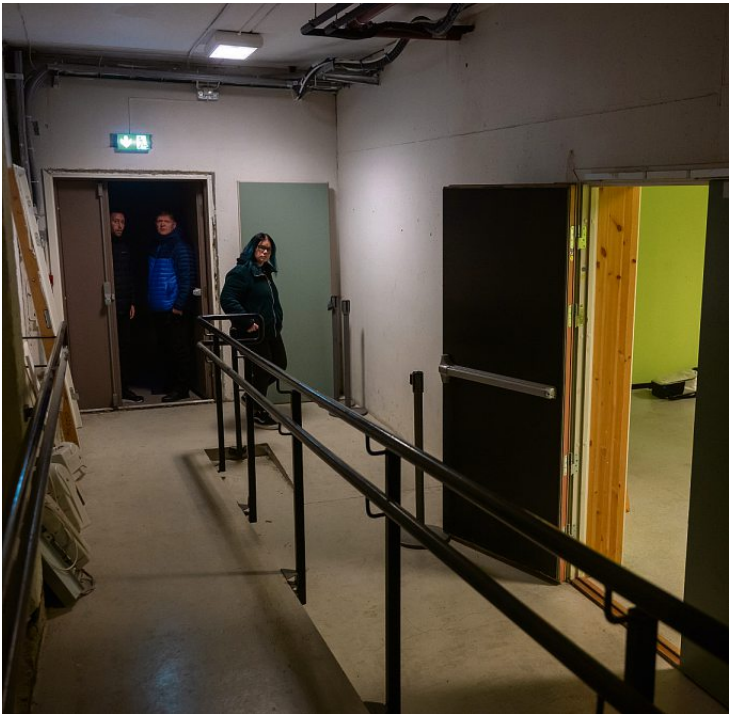
Inspeksjon av lokalet. Her er det tilrettelagt for at også rullestolbrukere skal komme seg inn i kjellerlokalet. Foto: Jørgen Haug
